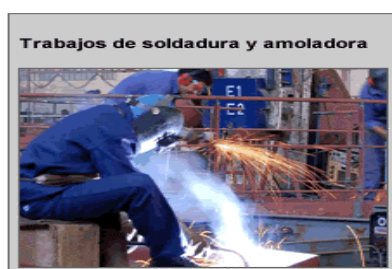
Trabajos que se realizan en el “Astillero Río Santiago”
